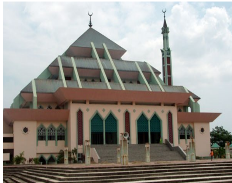
Figure 12 Foto masjid Agung sebelum direnovasi
